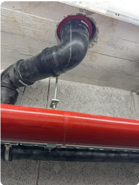
Plafond de la cave : traversée de canalisation
